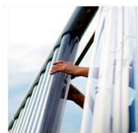
Figura 4: Coletor solar de tubo a vácuo
